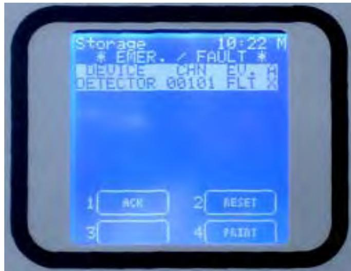
Fig. 3.2.1.d) Pantalla que muestra un estado de AVERÍA (*FAULT*) con los EVENTOS ACTIVOS.
