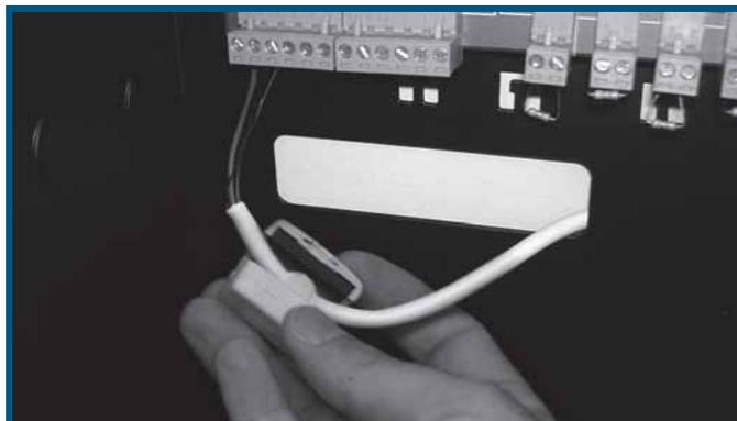
**Figura 18 - Ferritas para conductor de salida del lazo**
